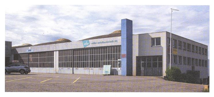
▲ 17 Die Fabrikhallen der Müller Metallbautechnik AG wurden 1964-1979 mithilfe der innovativen Betonschalenkonstruktion von Ingenieur Heinz Isler in Systembauweise entwickelt.
