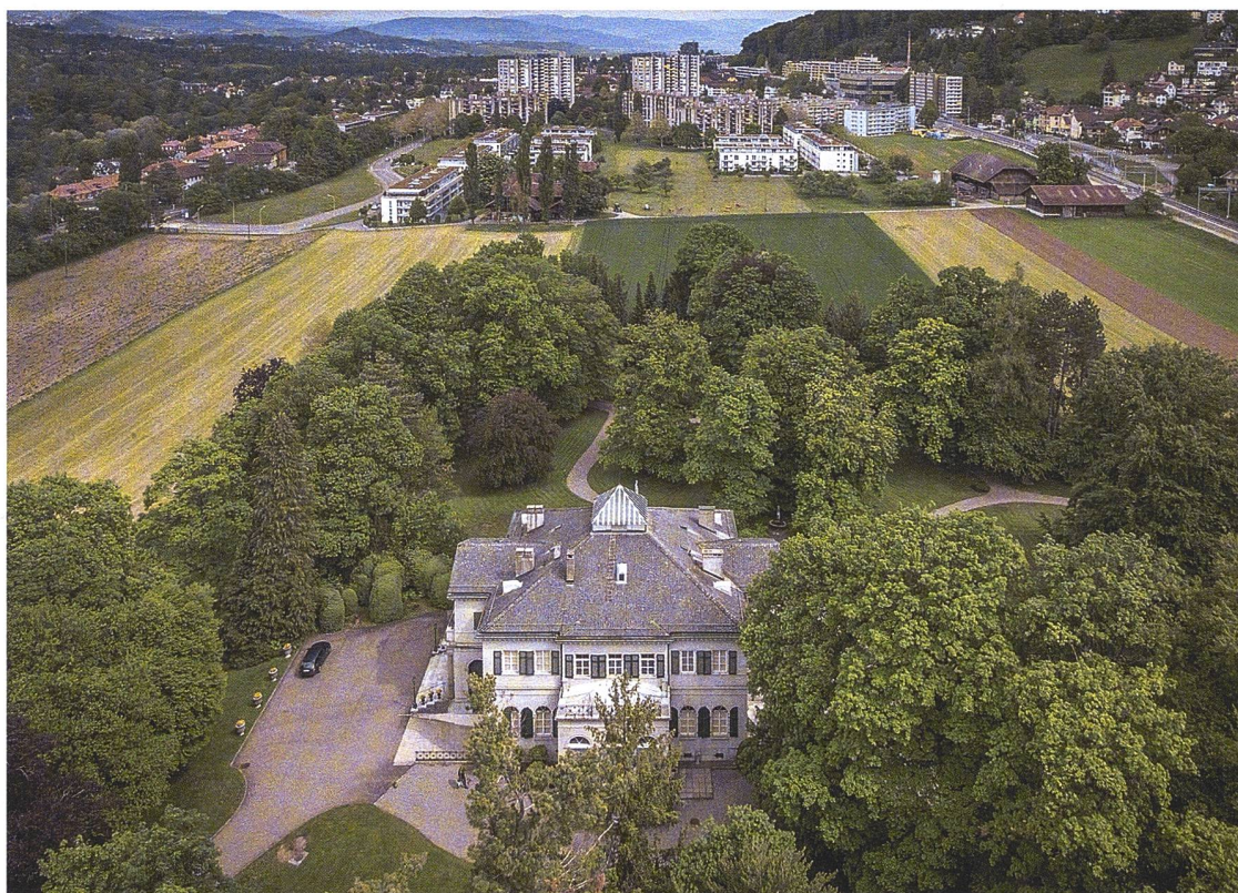
◀ 1 Der Bau der Villa Morillon wurde von Alette Sophie Rosina von Wattenwyl in Auftrag gegeben, die 1829 das Gut erbt.
