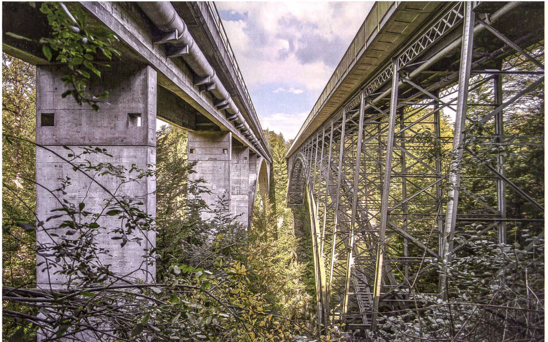
► 6 Die neue Eisenbahnbrücke von 1979 (links) und die Strassenhochbrücke in Eisenschwergitterwerk von 1882 (rechts).
