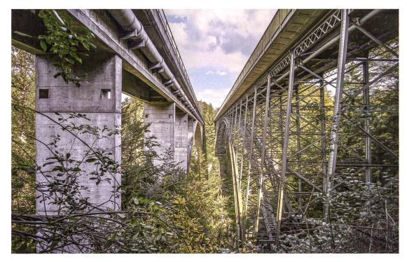
▶ 6 Die neue Eisenbahnbrücke von 1979 (links) und die Strassenhochbrücke in Eisenfachwerk von 1882 (rechts).
