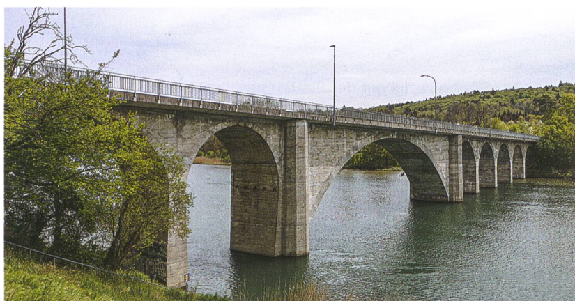
▼ 6 ... wurden die BKW 1917 zum Bau der neuen, 174 m langen und zweispurigen Hinterkappelenbrücke verpflichtet. Die armierte Betonbogenbrücke wurde 1920 eröffnet.
