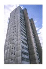
▲ 1 Vorläufer des Vollelementbaus in Bern: Die aus vorfabrizierten Sandwich-Betonelementen bestehenden Fassaden des 1959-1965 errichteten Tscharnerguts verleihen den Hoch- und Scheibenhäusern den Charakter von Plattenbauten.
