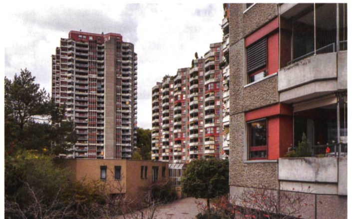
▲ 2 ... bis zur Überbauung Holenacker bilden die Siedlungen ein einmaliges Ensemble, an dem sich verschiedenste Architekturströmungen und gesellschaftliche Bedürfnisse vergangener Jahrzehnte ablesen lassen.
