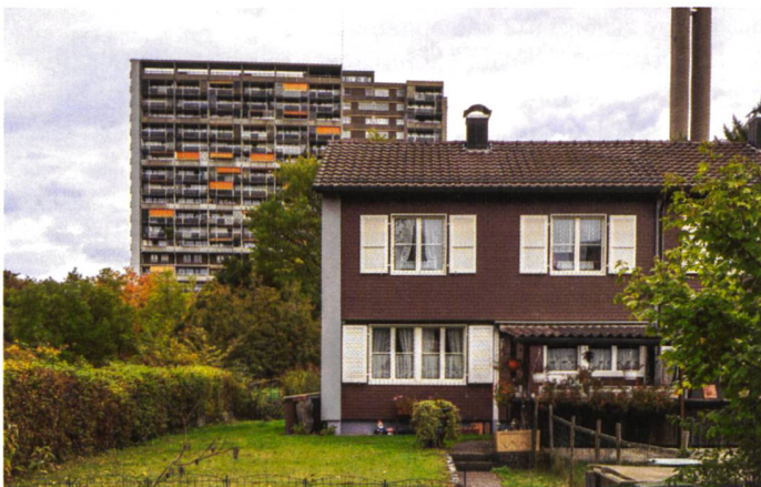
▲ 1 Im Führer werden die zehn wichtigsten Siedlungen der Nachkriegszeit in Bümpliz-Bethlehem im Detail vorgestellt. Von einer der ersten sogenannten «Kriegssiedlungen» im Bethlehemacker ...
