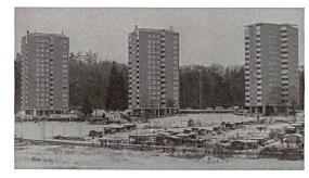
4 24 ▲ 25 Die drei Hochhäuser an der Holligenstrasse 101, 109 und 121 am Rand des Könizbergwalds aus den Jahren 1960-1961 von Willi Althaus (1912-1996). Im Originalzustand (links: Sichtbacksteinfassaden und schwebende Betonelemente über der Attika) verblieb auf Dauer nur der Bau rechts aussen, derweil die beiden anderen im Zuge von Nachisolationen mit Backsteinattrappen verkleidet wurden und ihren Dachschmuck verloren, Juli 1982 und Jan. 2010.
