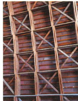
< > Höhepunkt der Flughafenführung ist für viele wohl die Besichtigung des «Bider-Hangars», der 1928 als erstes Gebäude für den Flugplatz Bern-Belpmoos errichtet wurde. Die aussergewöhnliche Bogenbinderkonstruktion aus vorgefertigten Holzelementen macht ihn zu einem bedeutenden Zeugen der Ingenieurskunst des frühen 20. Jahrhunderts.
