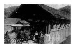
Pfeilern aus Eisenprofilen und Überspannungen aus Eichenholz errichtet. Da sich diese rasch abnutzte, wurde 1948–49 ausgehend von den bestehenden Zufahrten und Widerlagern eine Beton-Balkenbrücke mit Landpfeilern auf Einzelstützen und scheibenartigen Flusspfeilern erstellt. Die einfache, aber elegante Felsenaubrücke, deren Fahrbahn 1965 leicht angehoben und verbreitert wurde, wird mittlerweile durch Hochwasserschutzwände auf der linken Aareseite etwas bedrängt.
