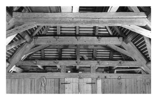
Eine Dämmung des Dachbodens ist in der Tat in vielen Fällen sowohl aus denkmalpflegerischer wie auch aus bauphysikalischer Sicht machbar. Hingegen ist die Sanierung der Dachfläche selbst nicht ganz so problemlos. Die aus bauphysikalischer Sicht beste Dämmung, die Aufsparrendämmung, verändert das Erscheinungsbild des Baudenkmals gravierend und die aus denkmalpflegerischer Sicht häufig angewandte Zwischensparrendämmung ist aus bauphysikalischer Sicht nicht ganz unbedenklich.
