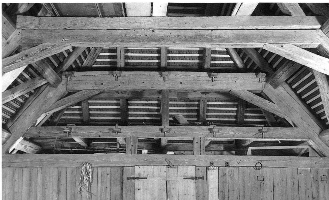
Eine Dämmung des Dachbodens ist in der Tat in vielen Fällen sowohl aus denkmalpflegerischer wie auch aus bauphysikalischer Sicht machbar. Hingegen ist die Sanierung der Dachfläche selbst nicht ganz so problemlos. Die aus bauphysikalischer Sicht beste Dämmung, die Aufsparrendämmung, verändert das Erscheinungsbild des Baudenkmales gravierend und die aus denkmalpflegerischer Sicht häufig angewandte Zwischenparrendämmung ist aus bauphysikalischer Sicht nicht ganz unbedenklich.
