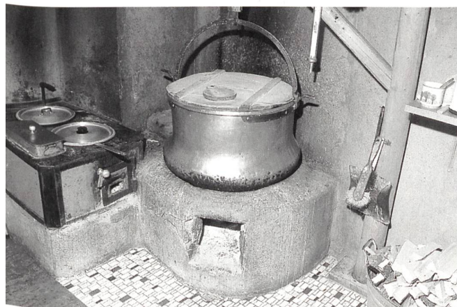
Adelboden, Engstligenalp: Spezielle Form der Feuergrube für das Käsekessi, typisch für das Frutigland.
