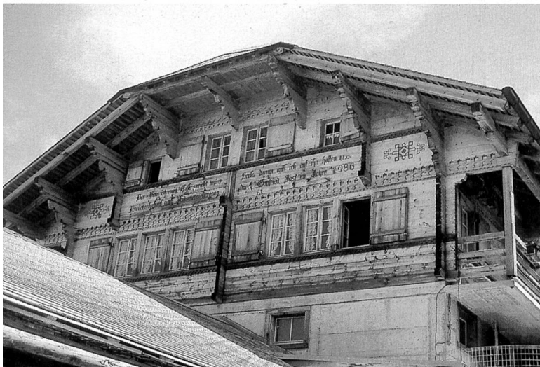
Alp Bonder, Adelboden: Alphütte nach neuem Schema, auf Betonsockel und Betonbodenplatte; erweiterte Bauinschrift von 1986.
