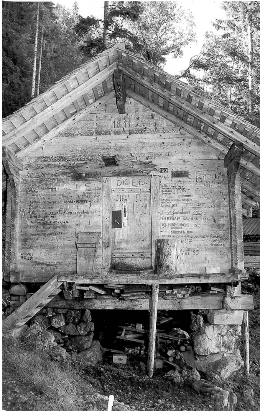
Künzlen, Bönigen: Käsespeicher von 1911 am Waldrand im steilen Hang, auf Steinblöcken und Schwellenkranz, mit Eingangsläubli; Graffiti verschiedenster Art und Herkunft.
