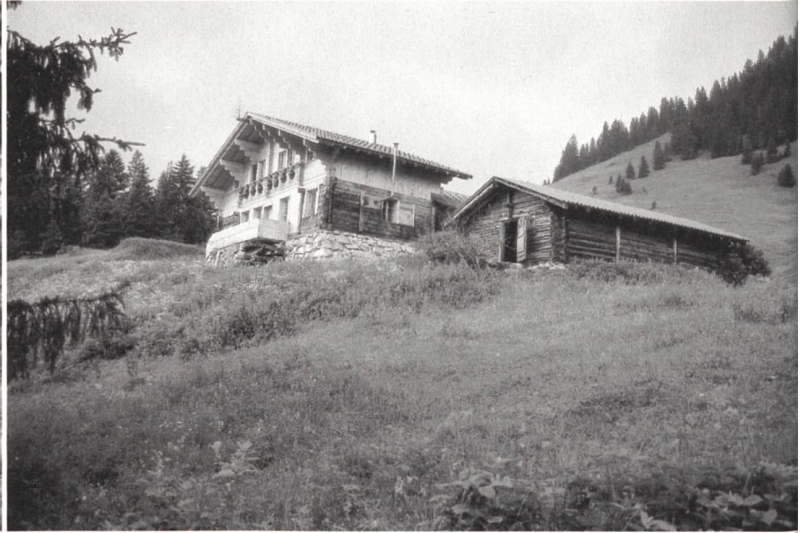
Saxeten, Alp Bällen: Altes Stallgebäude, daneben Alphütte mit neuem, überdimensioniertem, sonst gut gestaltetem Wohnteil.
