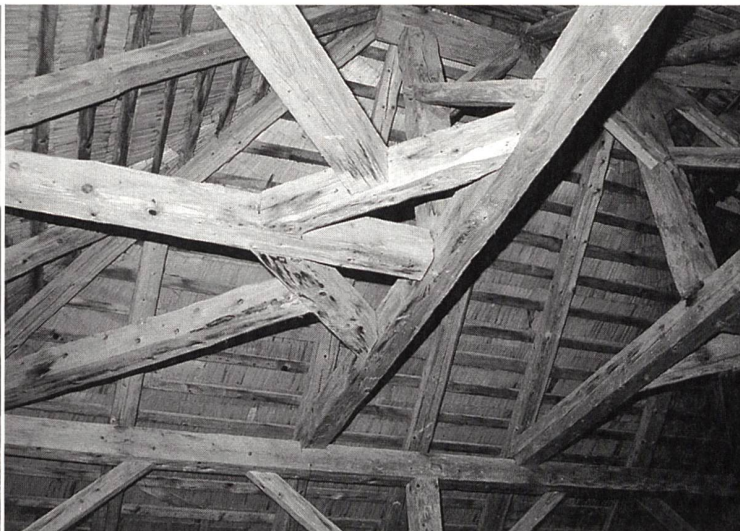
Erlenbach im Simmental, Unteres Heiti: Blick in den Dachstuhl einer Spitzhütte, ein eindrückliches Zimmermannskunstwerk.
