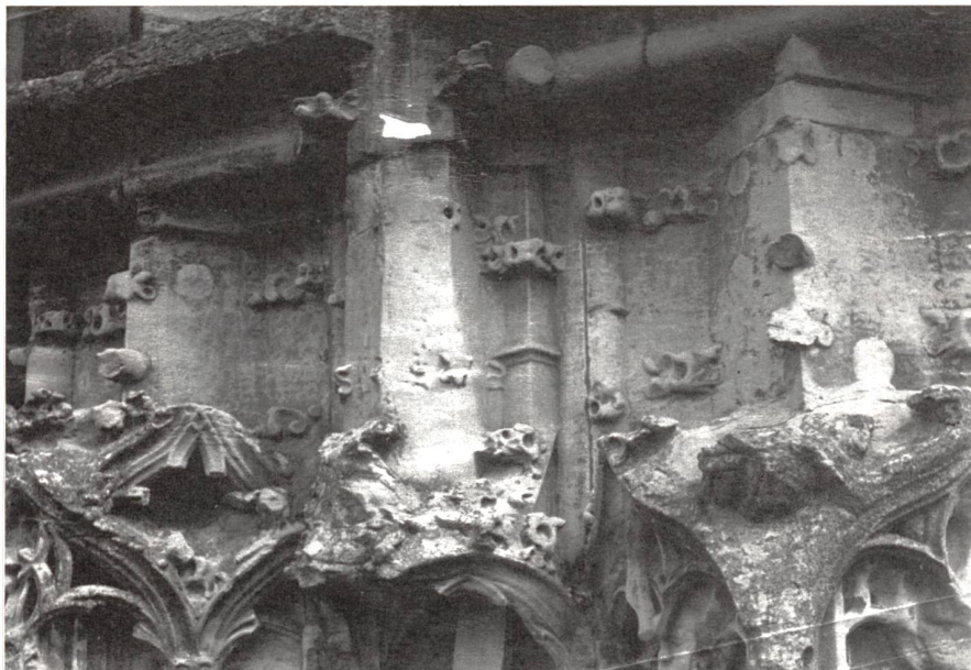
Oberes Viereck, Nordpfeiler. Die Rekonstruktion der Baldachingruppe erfolgte aufgrund dieser Fotografie aus der Zeit um 1900 sowie aufgrund der Masse, die an den Originalstücken abgegriffen werden konnten.
