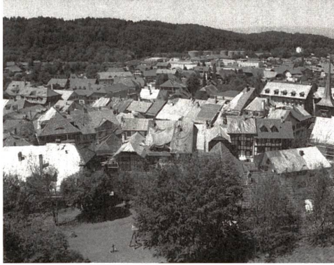
Blick auf die Laupener Altstadt vor und nach den Sanierungsmassnahmen.
