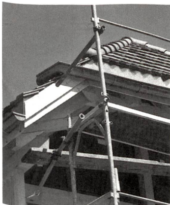
Detail eines neuen Daches. (Fotos: Peter Tanner)
