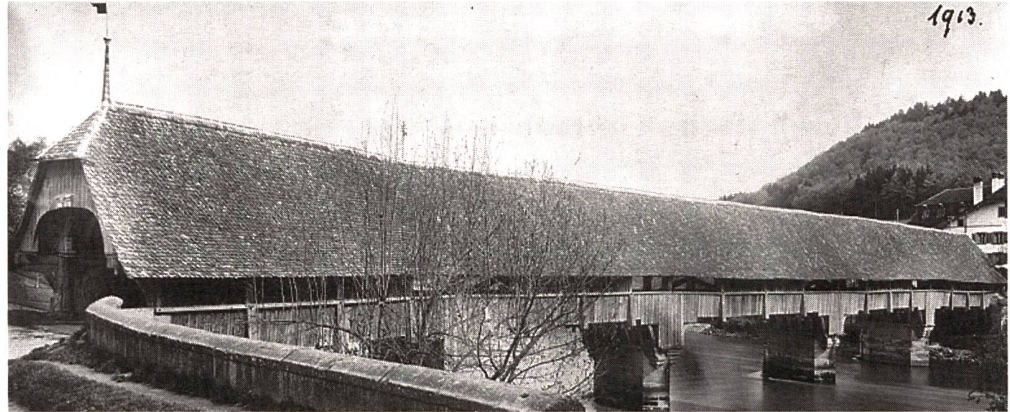
Neubücke. Die Holzkonstruktion ruht auf Steinpfeilern. (Foto: IVS, mit Bewilligung des Eidg. Archivs für Denkmalpflege)
