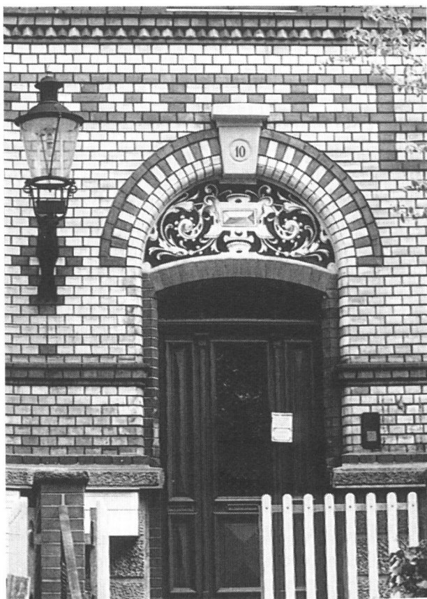
Sichtbackstein-Partie am Obstbergweg. (Foto: R. Hürlimann)
