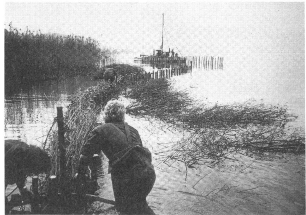
Bild 1: Bau der Lahnungen in Lüscherz
