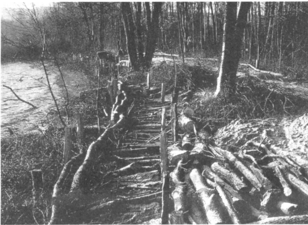
Bilder 4,5,6: Bau und Wachstum von Packwerk als lebende Uferbefestigung
