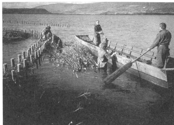
Bild 2: Bau der Lahnungen in Lüscherz
