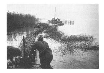
Bild 1: Bau der Lahnungen in Lüscherz
