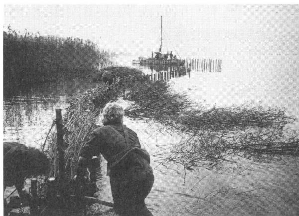
Bild 1: Bau der Lahnungen in Lüscherz
