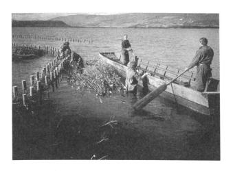
Bild 2: Bau der Lahnungen in Lüscherz
