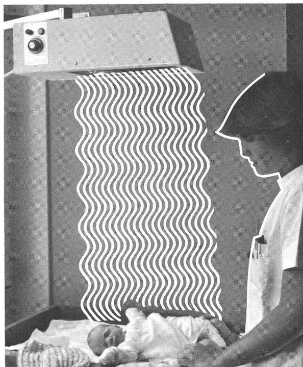
Dank der neuartigen, indirekt schrägstrahlenden Quarzheizung wird eine unnötige Wärmebestrahlung der Pflegeperson vermieden. Viel wichtiger ist jedoch, dass eine gleichmässige
