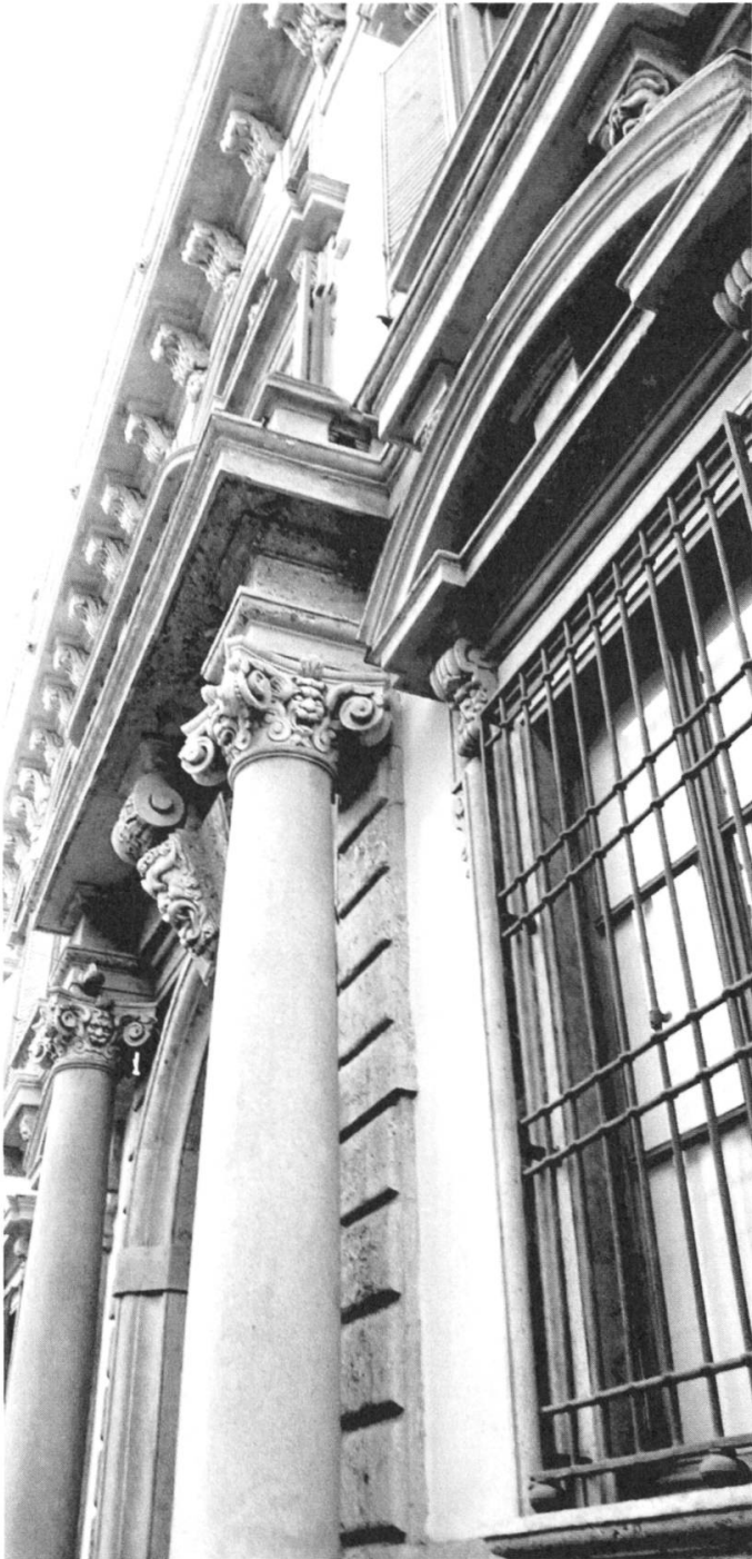
Fig. 1. Detail der Fassade von Palazzo Annoni, Corso di Porta Romana 6, Milano.
