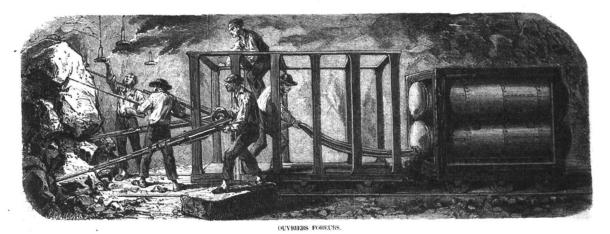
rig. 3. Illustrations des travaux pour le torage du tunnel du Fréjus dans un article de *L'illustration*. *Journal Universel*, XXXIX, 1862, p. 108.
