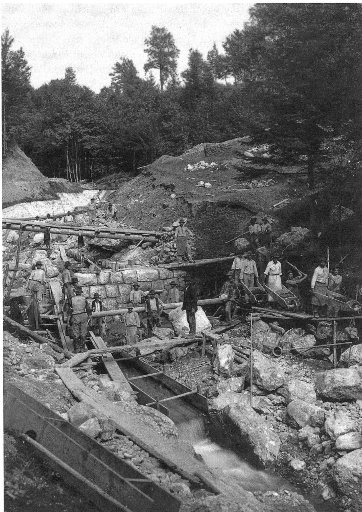
Abb. 3: Regulierungsarbeiten am Oberlauf des Alterbachs um 1905. Quelle: Archiv der Wildbachverbauung Salzburg.
