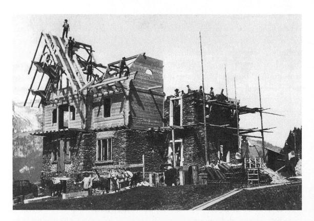
Abb. 5: Aufbau eines Chalets. Vor dem Rohbau stehen Maultiere für den Materialtransport. Quelle: Oskar Schärz, Firmenarchiv.
