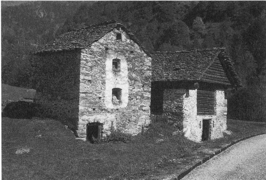
Abb. 3: Maiensäss («monte») mit gemauertem Feuerhaus und Pfeilerstall. Verputzte und getünchte Fensterumrahmung («collarino»). Das separate Schlafhaus befindet sich hinter den beiden Gebäuden. Fusio, Mogno. Foto: Max Gschwend, 1968.
