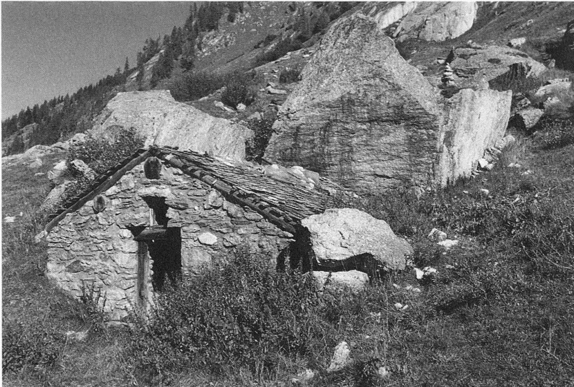
Abb. 4: Einräumige Sennhütte in Bruchstein mit Steinplattendach, um 1950. Sie lehnt sich in spätmittelalterlicher Tradition zum Schutz an einen grossen Block eines Felssturzes an. Ulrichen, Arenäst. Foto: Benno Furrer, 2006.
