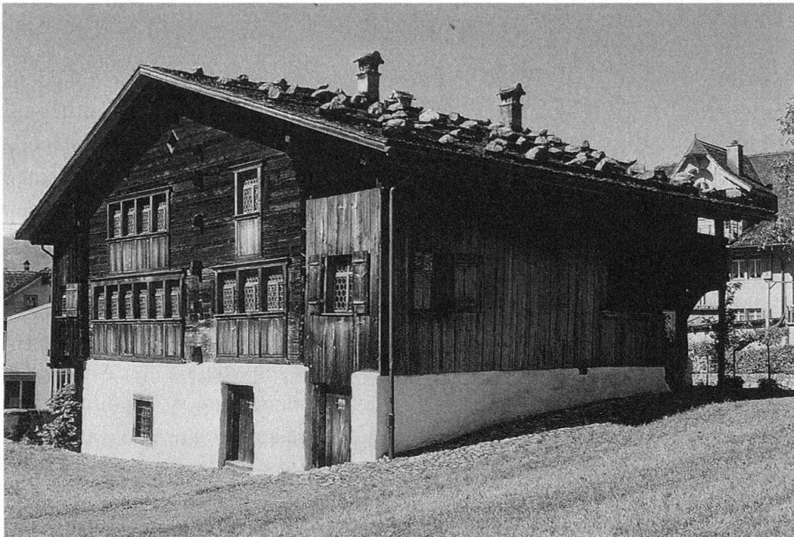
Abb. 1: Spätmittelalterlicher Blockbau aus dem Jahr 1287. Schwyz, Haus Bethlehem. Foto: Benno Furrer, 2001.
