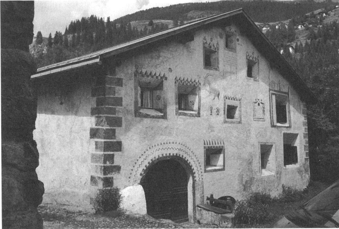
Abb. 5: Vielzweckbau mit Wohnteil und nachträglich angebauter Stallscheune. Hinter dem Mauerwerk bestehen Stuben und Kammern als hölzerne Kompartimente in Blockbauweise. Fassadenmalerei von 1554 mit geometrischen Ornamenten, Inschriften, Tierfiguren sowie einer Sonnenuhr. Bergün, Unterdorf Nr. 47. Foto: Benno Furrer, 2008.
