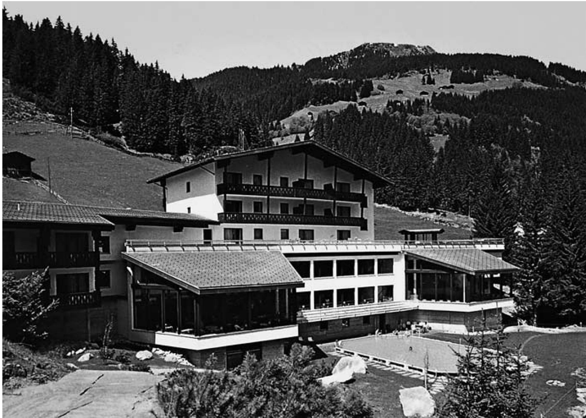
Abb. 2. Der heute leer stehende und architektonisch wenig überzeugende Hotelneubau des Tenigerbads. Quelle: StAGR, FR XXIII 493, Postkarte, circa 1974.
