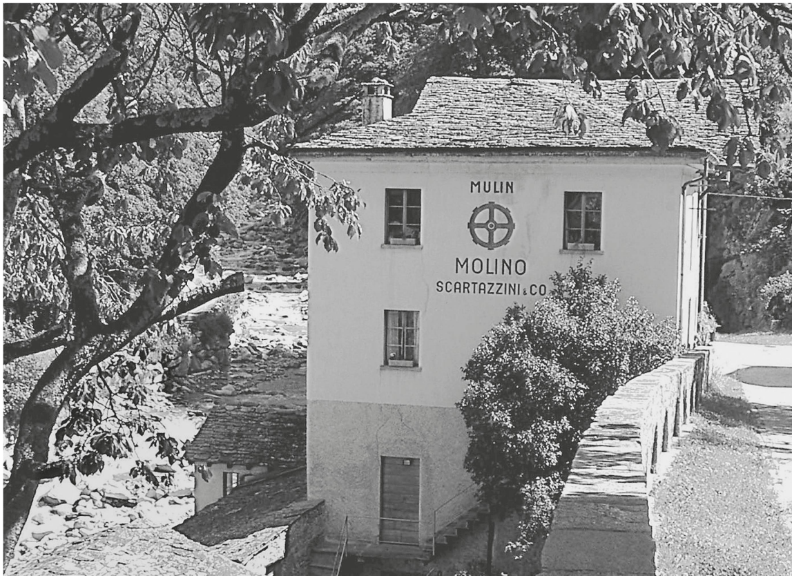
Abb. 3: Zu den frühen Gewerbebetrieben, die Strom an die Nachbargemeinden lieferte, gehörte die Getreidemühle Scartazzini in Promontogno im Bergell. Nach dem Bau der Bergeller Kraftwerke übernahm die Stadt Zürich die Versorgung. Foto: Emmi Caviezel.
