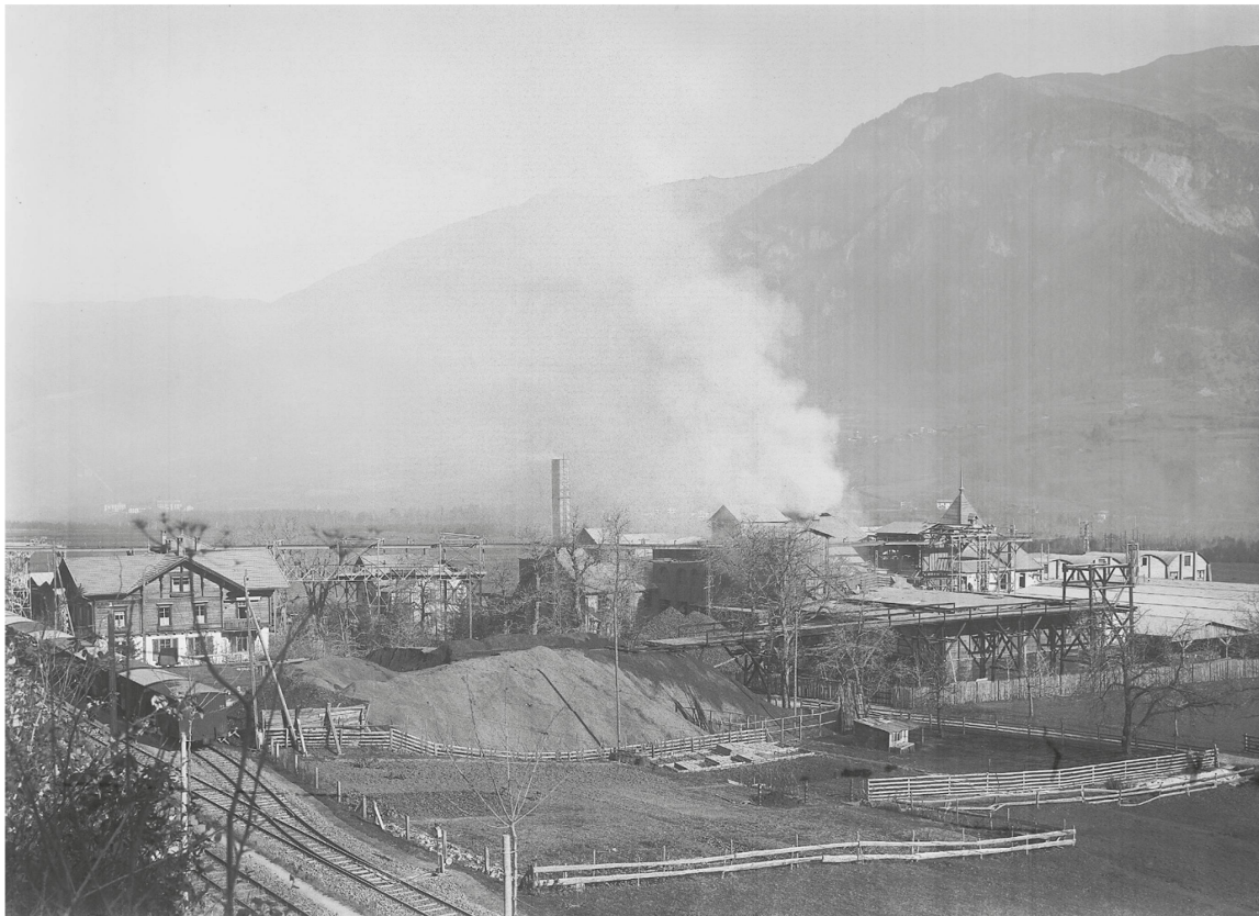
Abb. 1: Das erste und lange einzige Industriekraftwerk Graubündens war die glücklose Karbidfabrik in Thusis. Quelle: Foto Archiv Rhätische Werke, Thusis.
