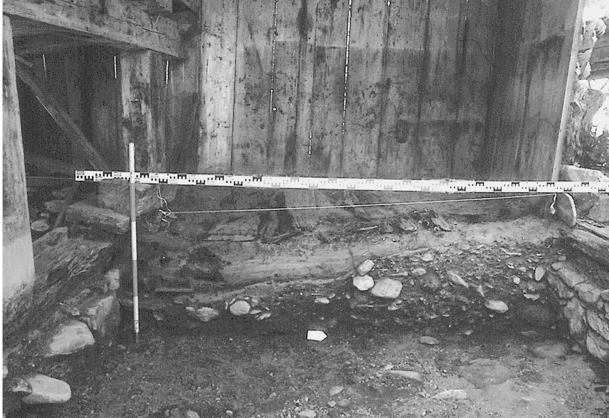
Abb. 1: Hafnerei Steger. Glasurmühle mit archäologischen Befunden der Überschwemmungshorizonte des 19./20. Jahrhunderts. Foto: H. Stadler.
