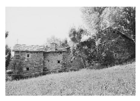
III. 1: Echallogne (Arnad). Adret de la basse vallée centrale. Un exemple d'ensemble complexe. Les maçonneries non enduites permettent une «lecture» des phases de construction.
