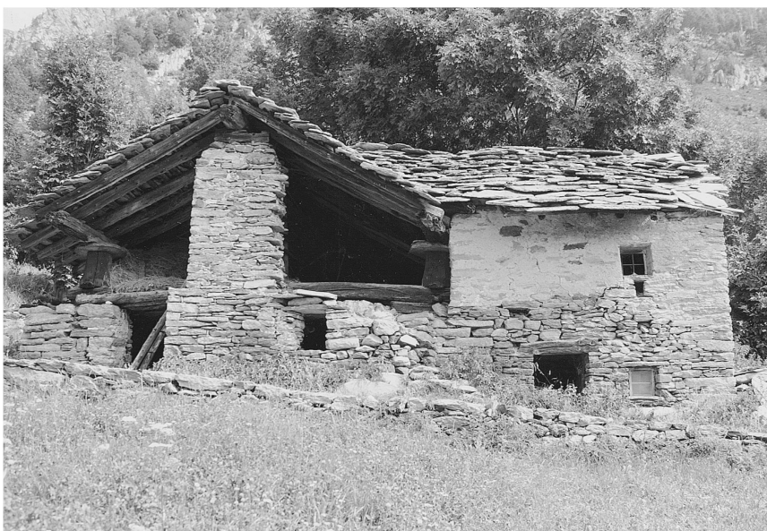
III. 2: Echallagne. À gauche, dépendance céréalière pour le séchage des javelles. Observer les supports récupérés d'un «raccard» préexistant.
