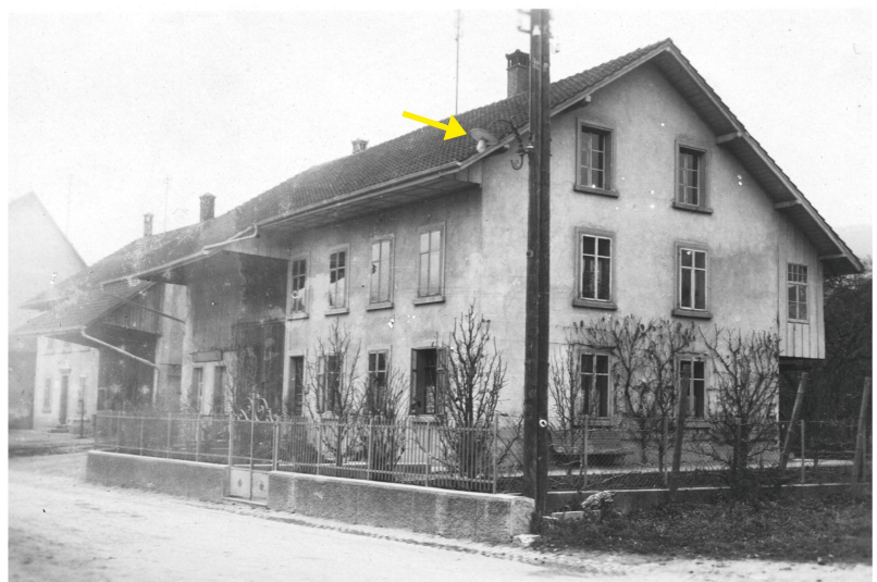
Abb. 17 – Foto um 1925: Strassenlaternen wurden wenn immer möglich an hölzernen Stromleitungsstangen angebracht wie hier an der Solothurnerstrasse 6 beim «Schriner-Wysse-Huus».
