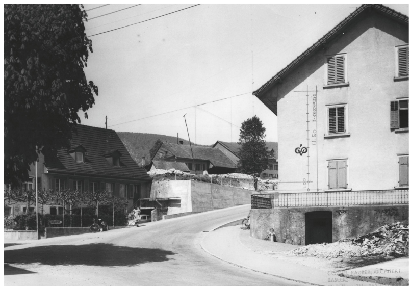
Abb. 16 – 1963: Das Haus des Alois Flury auf dem Hübeli ist abgebrochen und die Zyklopenmauer durch eine Betonmauer ersetzt.
