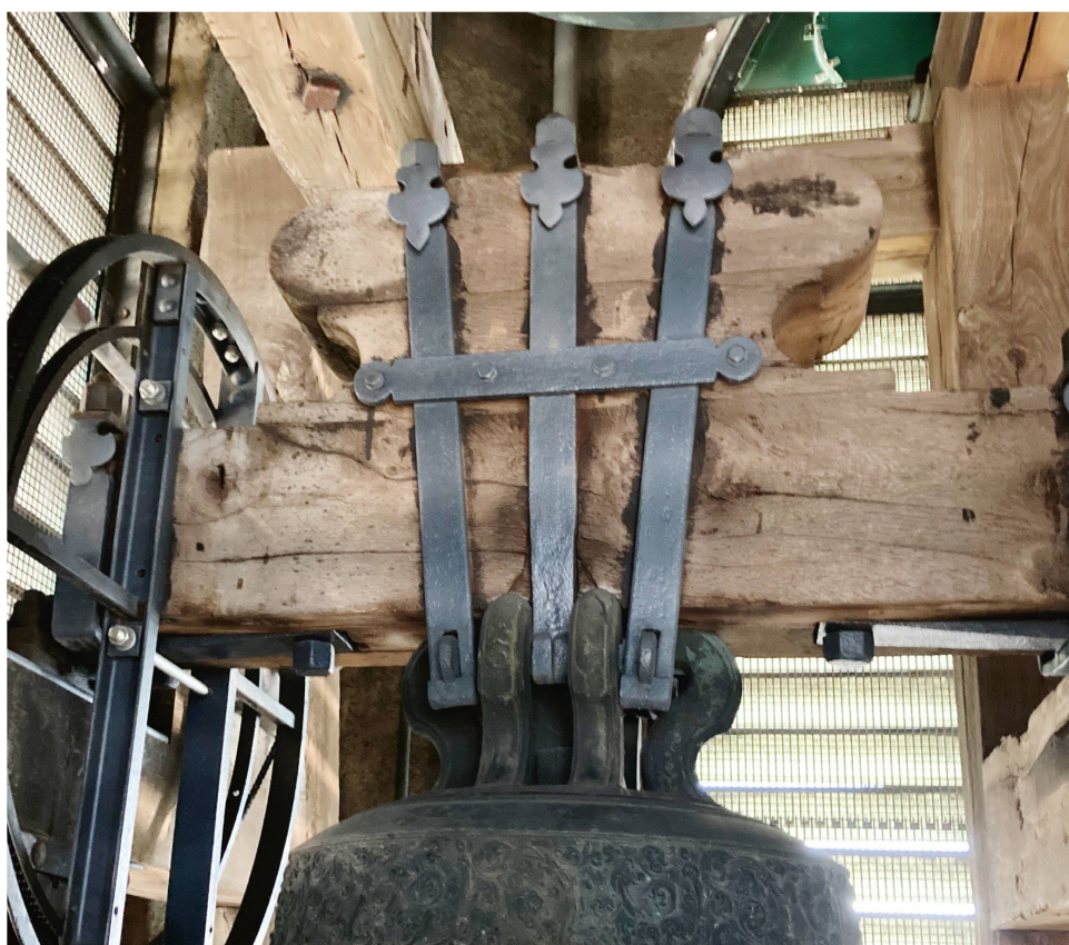
Abb. 5 – Der aus Eichenholz gefertigte Glockenstuhl, das Glockenjoch (Mitte) und die Eisenbeschläge tragen das Geläut seit 1863. Siebzig Jahre später hatte das schweisstreibende Läuten der Glocken mit Seilen dank dem Einbau von Elektromotoren ein Ende.
