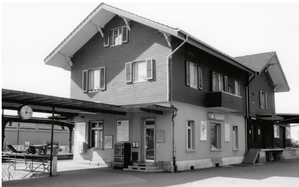
Abb. 26 Das Bahnhofgebäude im Jahre 1994: Aus der nordseitigen Eingangstüre zu Schalter und Wartsaal ist ein Fenster geworden. Auf der Giebelseite verfügte das Erdgeschoss ursprünglich über drei Fenster. Das mittlere ist zugemauert und dasjenige rechts ist zum neuen Eingang erweitert. Das Fachwerk des Obergeschosses ist mit Faserzementschindeln verkleidet und ein kleiner Balkon ragt aus der Fassade.
