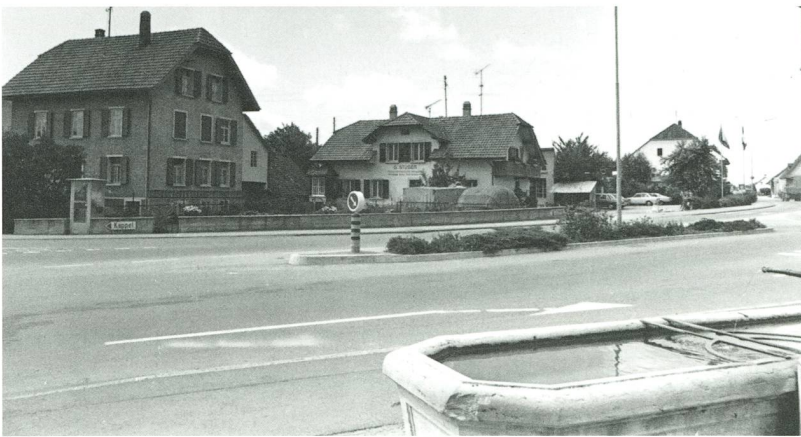
Abb. 13 – Durch den Abbruch der Wirtshäuser Kreuz und Schweizerhaus wurde Platz für eine grosszügige durch Inseln getrennte Verkehrsführung geschaffen. Foto um 1975.
