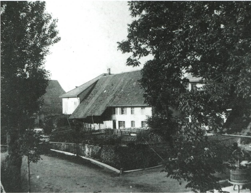
Abb. 10 – Bachstrasse unterhalb des Kirchrains um 1930. Das Haus hinter dem Dorfbach, Bachstrasse 26/19, hat eine bewegte Geschichte. Im Erdgeschoss wurde einst eine Schmiedewerkstatt, später eine Spenglerei betrieben. Die Lokalitäten werden nun schon seit längerem als Schneiderei und Stoffgeschäft genutzt.
