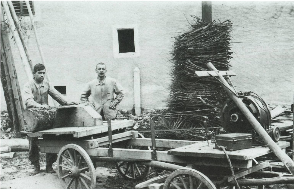
Abb. 9a – Infolge Benzin- knappheit während des 2. Weltkrieges erledigte Hänggi seine Aufträge mit einer elektrisch betriebenen auf einem Brückenwagen mon- tierten Kreissäge. Links Ernst Hänggi, rechts sein Schwager Ernst Kamber- Hänggi, hinten Reiswel- lenbündel.
