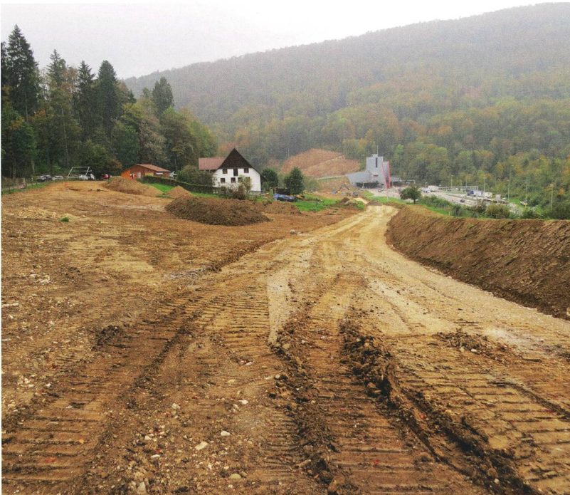
Abb. 2 – Blick über die untersuchte Fläche gegen Norden. Im Vordergrund und links im Bild der steinige Untergrund, der auf ältere Erdabträge in diesem Bereich hinweist. Im Hintergrund der Mittlere Richenwilhof und das Südportal des Belchentunnels.
