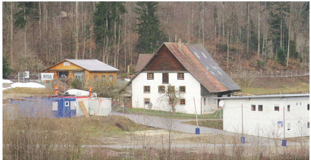
Abb. 20 Von den drei Richenwil-Höfen existiert heute einzig noch der Mittlere. Er ist momentan wegen dem Bau der 3. Belchenröhre von Baucontainern und Baracken umstellt.
