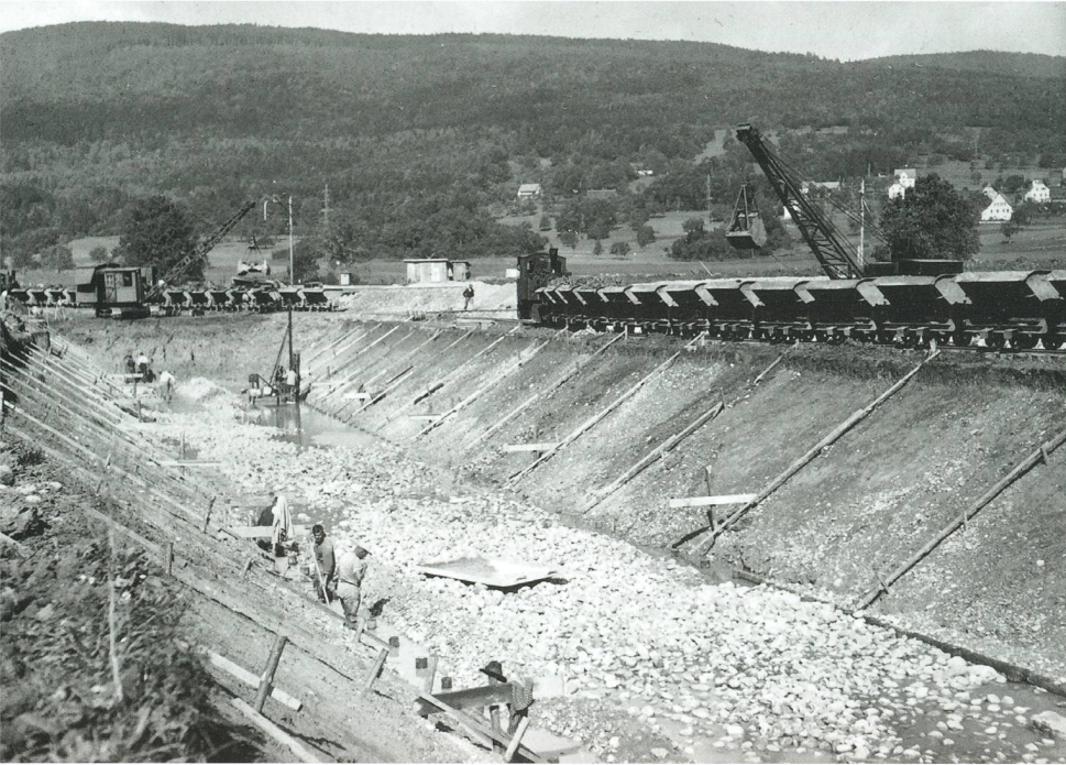
Abb. 14 – Bauarbeiten bei Hägendorf.
