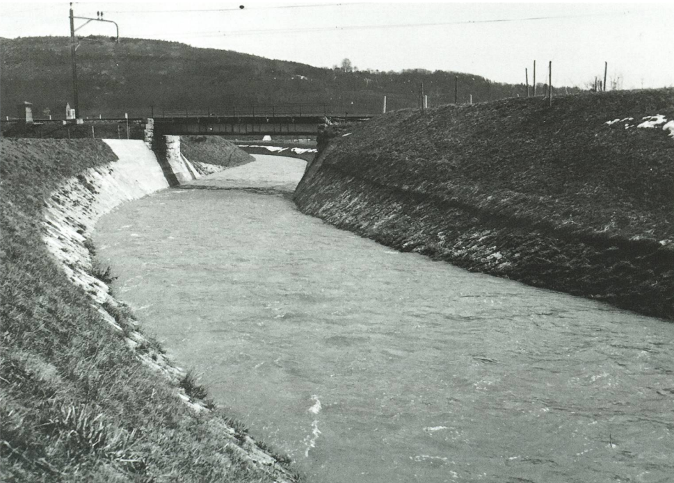
Abb. 15 – Blick vom «Dreiländereck» bei der Pritschenmatt flussabwärts zur Eisenbahnbrücke.
