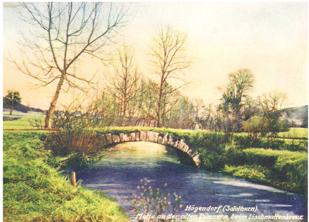
Abb. 14 – Anstelle des zerbrochenen «Brüggli bei der Zuchtstiermatte» wurde 1870 am gleichen Ort diese Steinbogenbrücke gebaut. Ansichtskarte.
