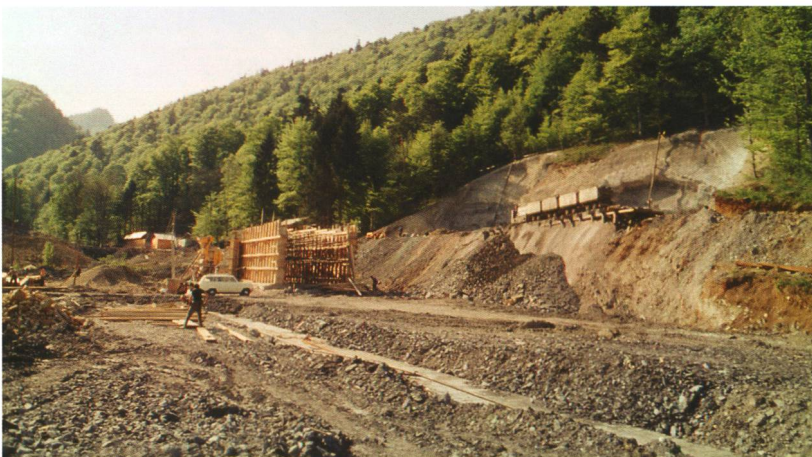
Die Tunnelbaustelle aus dem Talgrund gesehen. Die Transportbahn (rechts) am Entladeplatz
