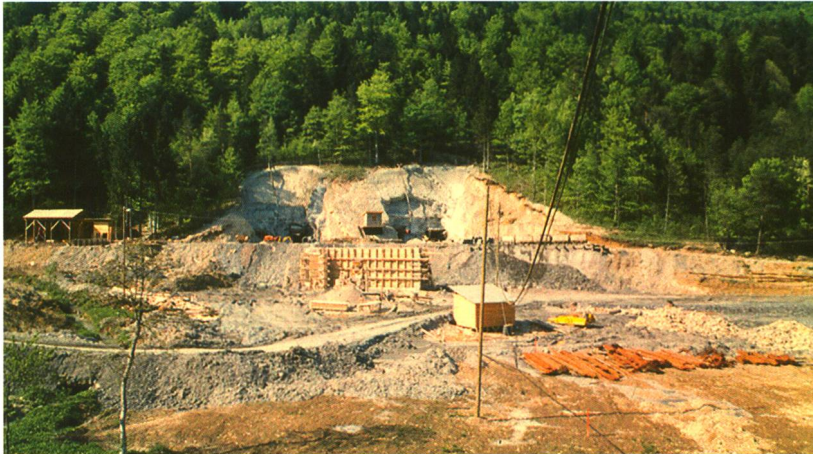
Die Tunnelbaustelle von Süden. Eine kleine Bahn (rechts des Tunnel- portals) transportiert das beim Vortrieb der Sohlstollen anfallende Ausbruch- material aus dem Berg. Im Lokdepot (links) wurden die Zugmaschinen gewar- tet und deren Batterien aufgeladen.
