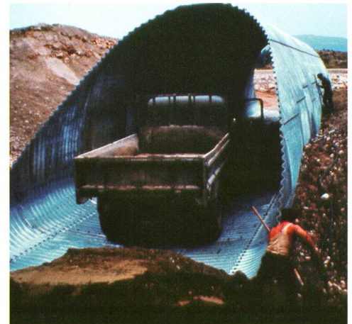
Der Durchlass im Santel entsteht.
