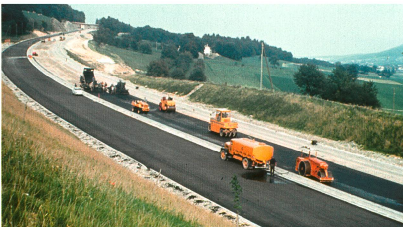
Belagseinbau auf der Belchen-Südrampe
