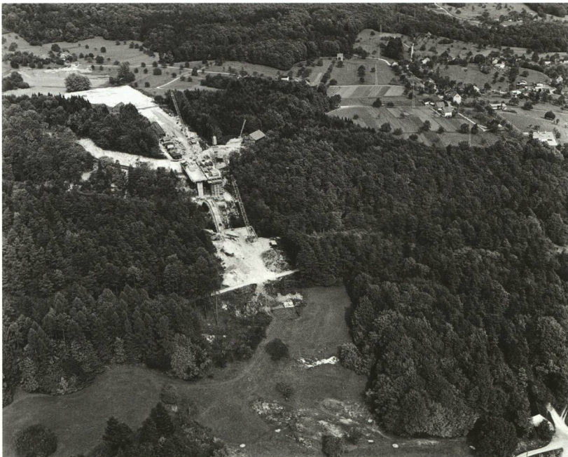
Baustelle Teufelsbrücke von Südwesten. Rechts unten ist das «Schürli» im Heiligacher zu erkennen. Der Spitzacker und das Ernetfeld rechts oben sind noch nicht überbaut.
