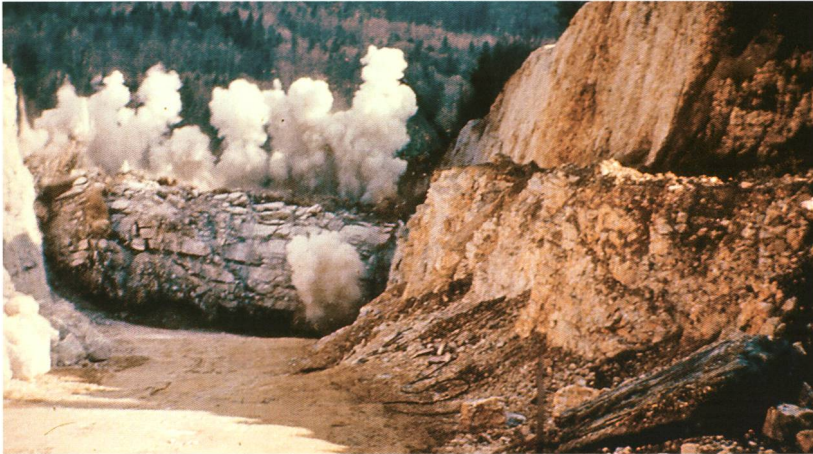
Sprengung im Balmeinschnitt
