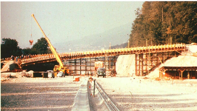
Die Überführung Teufengraben wird betoniert.
