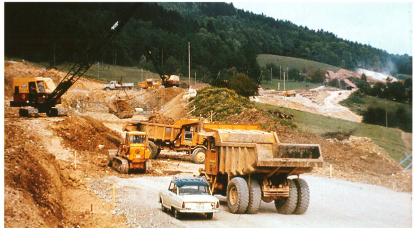
Trasseebau. Der alte Santel-Hof (rechts hinten) ist noch nicht abgebrochen.
