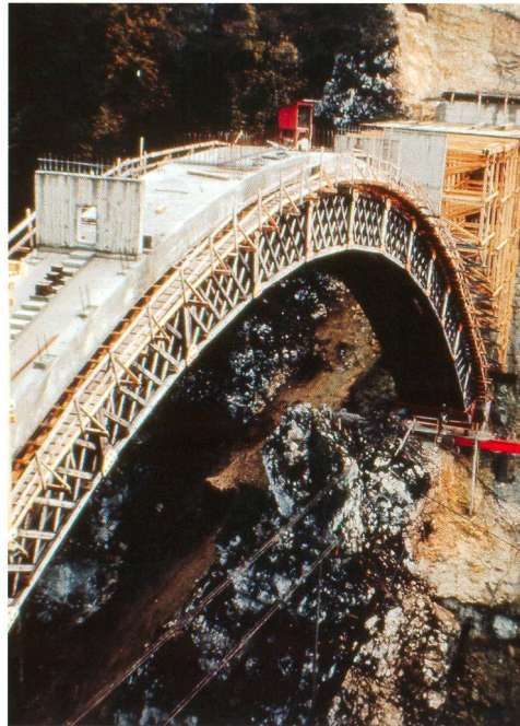
Teufelsbrücke: Der Bogen ist betoniert.
