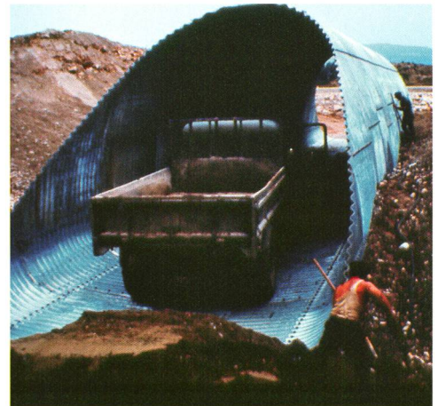
Der Durchlass im Santel entsteht.
