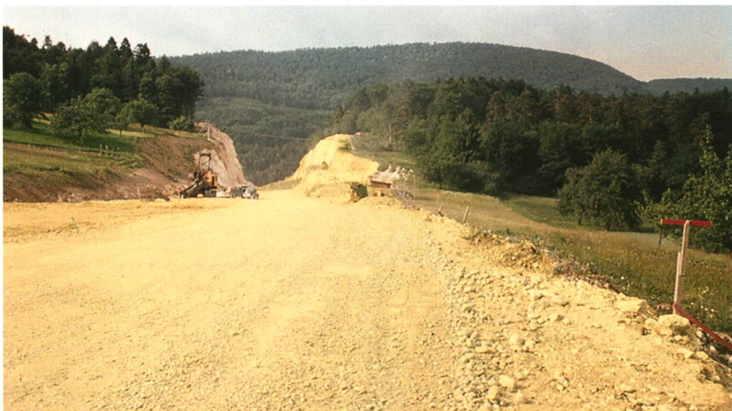
Der Durchstich ist geschafft.
