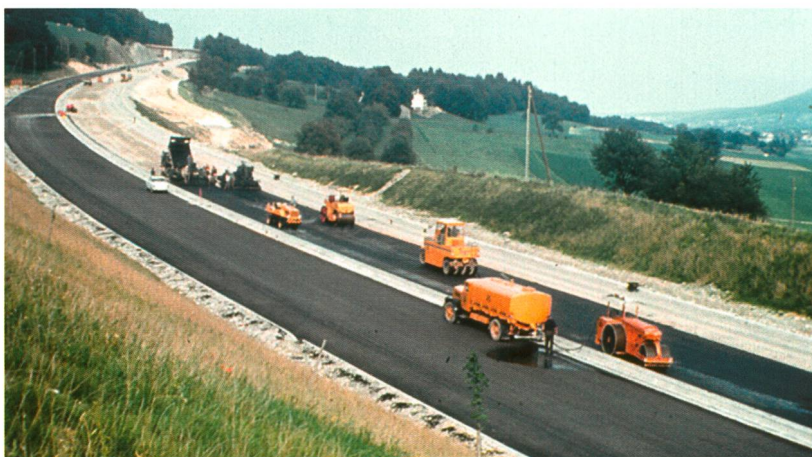
Belagseinbau auf der Belchen-Südrampe
