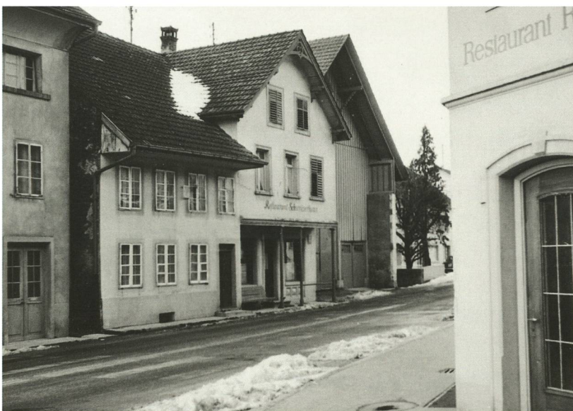
Restaurant «Schweizerhaus» vor dem Abbruch im Februar 1962
