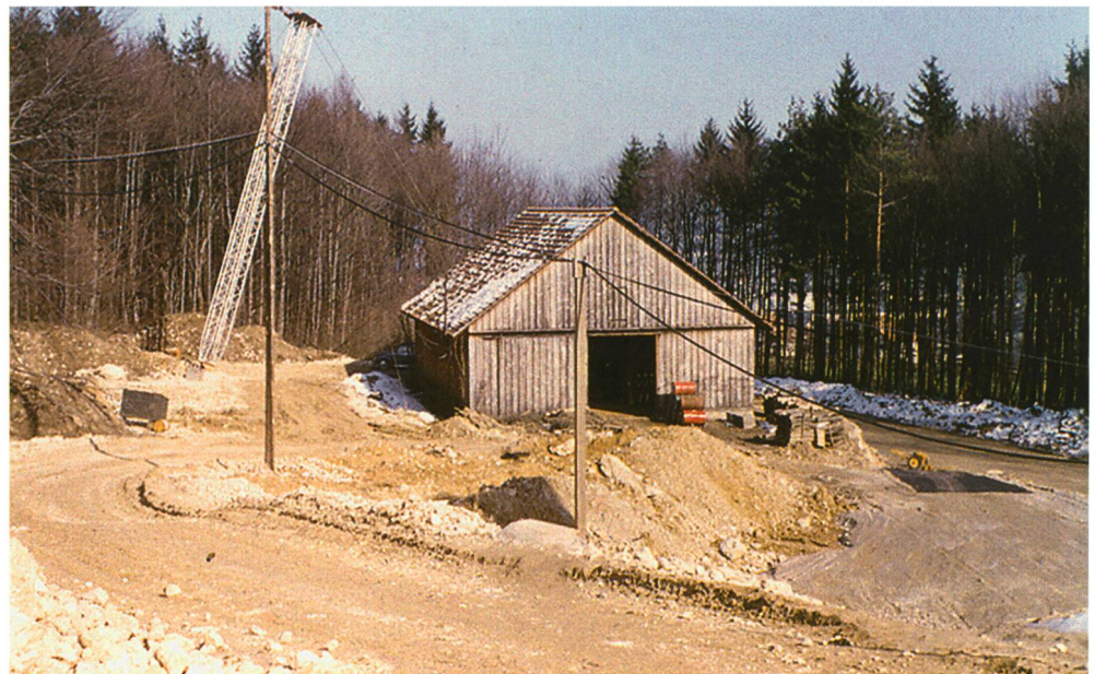
Das 1944 erstellte «Holzhaus» zwischen der Baustelle Teufelsbrücke und der Allerheiligenstrasse
