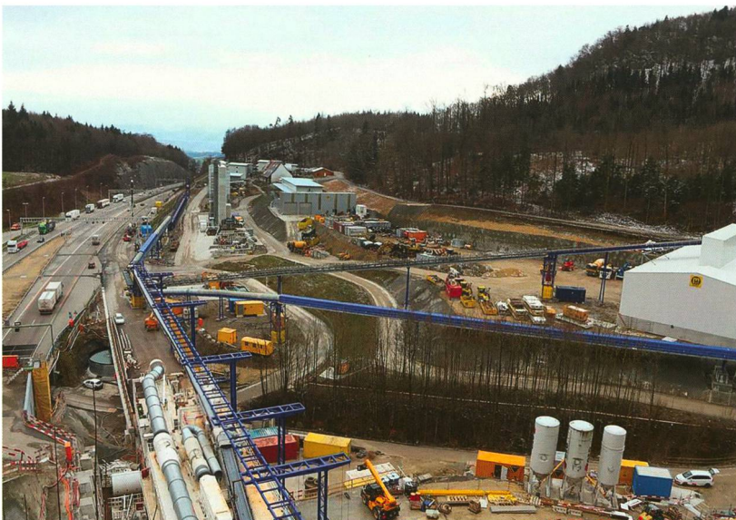
Tunnelbaustelle Richenwil im Februar 2016
