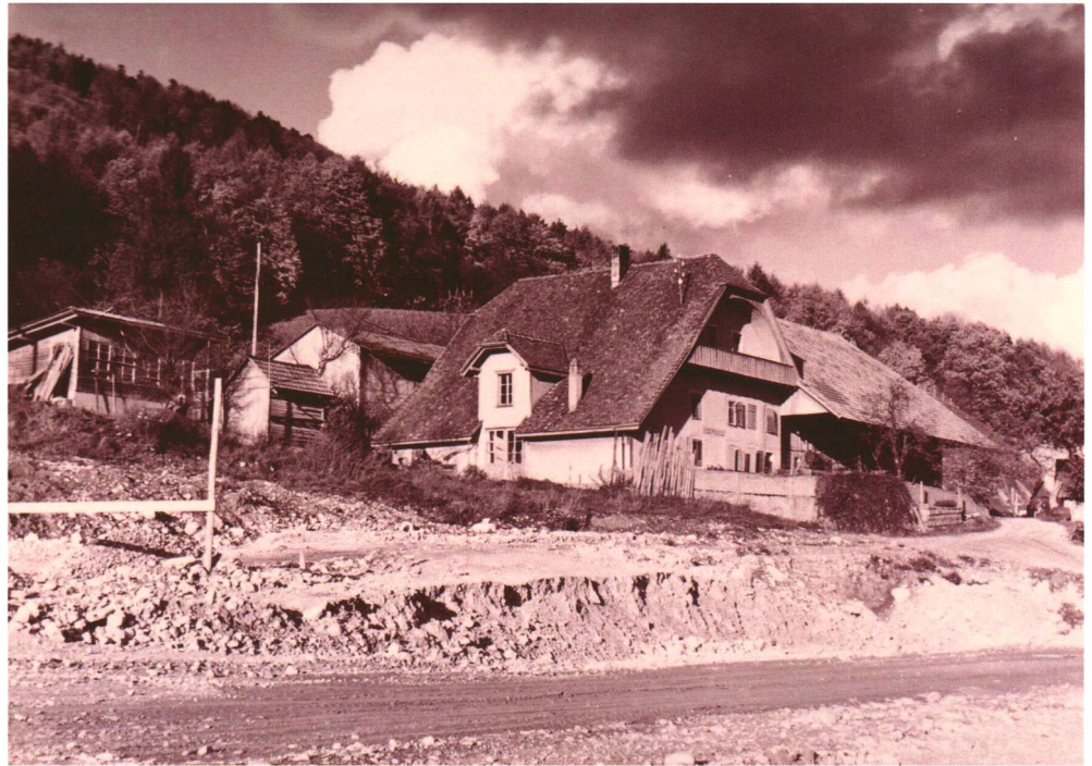
Der alte Santelhof kurz vor dem Abbruch
