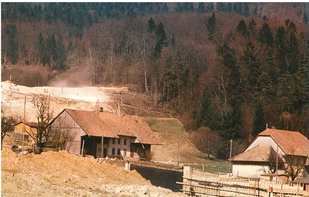
Links der Hufschmid-Hof, rechts das Haus des Gottlieb Kamber kurz vor dem Abbruch. Hinten wird am Balm-Durchbruch gearbeitet, rechts vorne entsteht die Gnöd-Unterführung.
