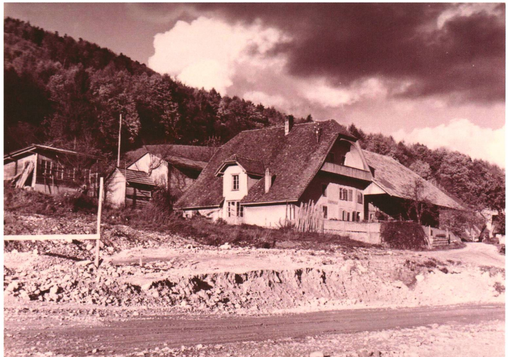
Der alte Santelhof kurz vor dem Abbruch
