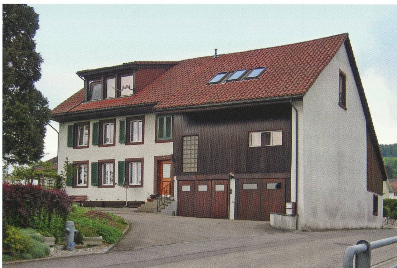
Das Haus Nr. 189 (25) dürfte zwischen 1835 und 1840 gebaut worden sein.
