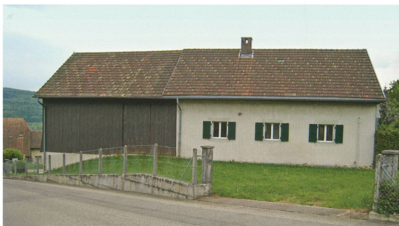
Nordansicht des Hauses Nr. 45 (23)
