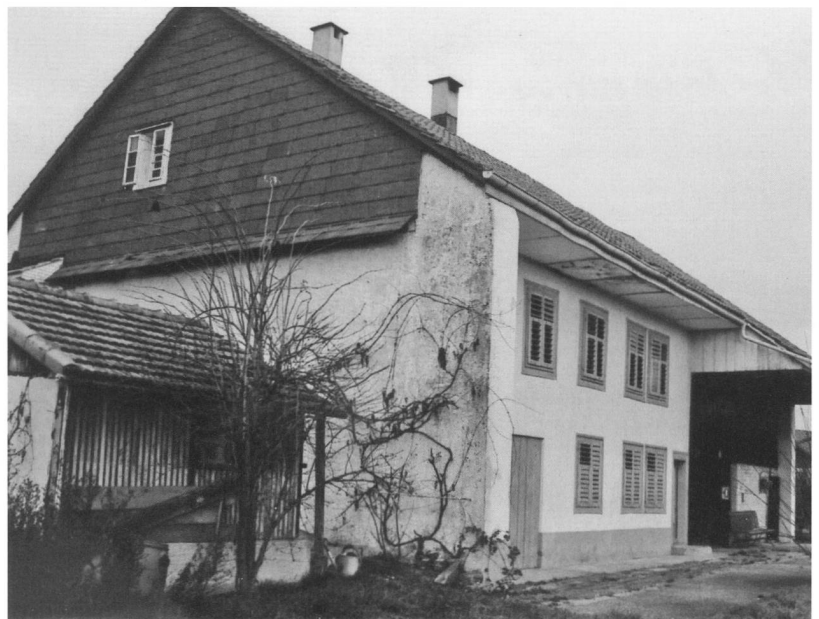
Das Haus Nr. 40 (19) wurde 2002 abgebrochen.
