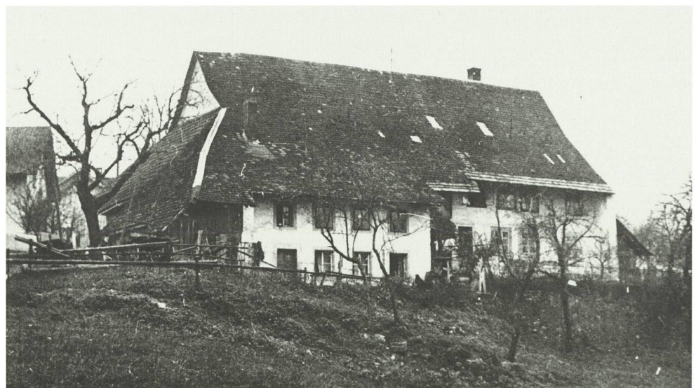
Das Haus Nr. 37 brannte 1968 ab. An seiner Stelle steht nun das Mehrfamilienhaus Nr. (6).
