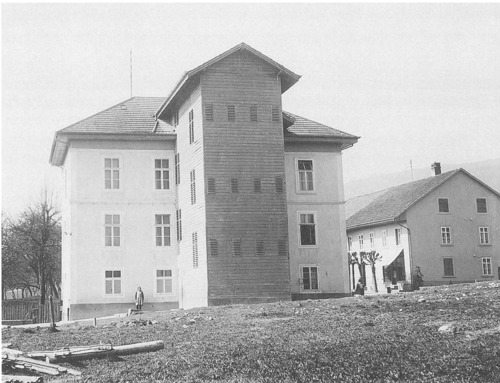
Das 1888 aufgestockte erste Schulhaus mit dem ostseitigen Treppenhaus- und Abort-Anbau: Im Hintergrund rechts die ehemalige Tuchhandlung von Christian Rötheli, «s Schuelänge-Hus», Sitz der Oberschule, dann der Gemeindeverwaltung, abgebrochen 1991
