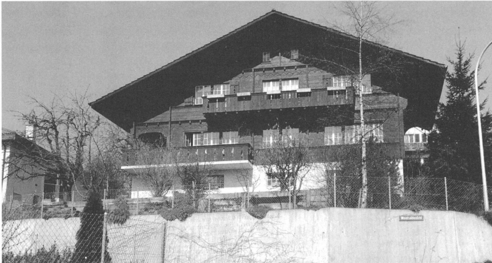
Abb. 6 ... und das Zweifamilien- Chalet am Vogelberg 17 fan- gen mit ihren nach Süden gerichteten Fensterfronten das Sonnenlicht ein.
