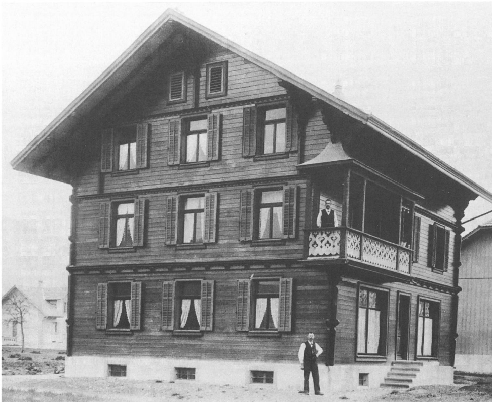
Abb. 1 Haus Bahnweg 2 in ursprünglichem Zustand ohne Verkleidung und mit den zwei Schaufenstern für den geplanten Verkaufsladen im Erdgeschoss (ca. 1915) ...
