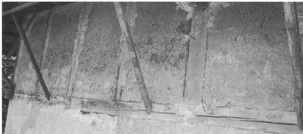
Abb. 7 Die Wände des Obergeschosses bestanden aus einem mit Lehm ausgestrichenen Rutengeflecht.
