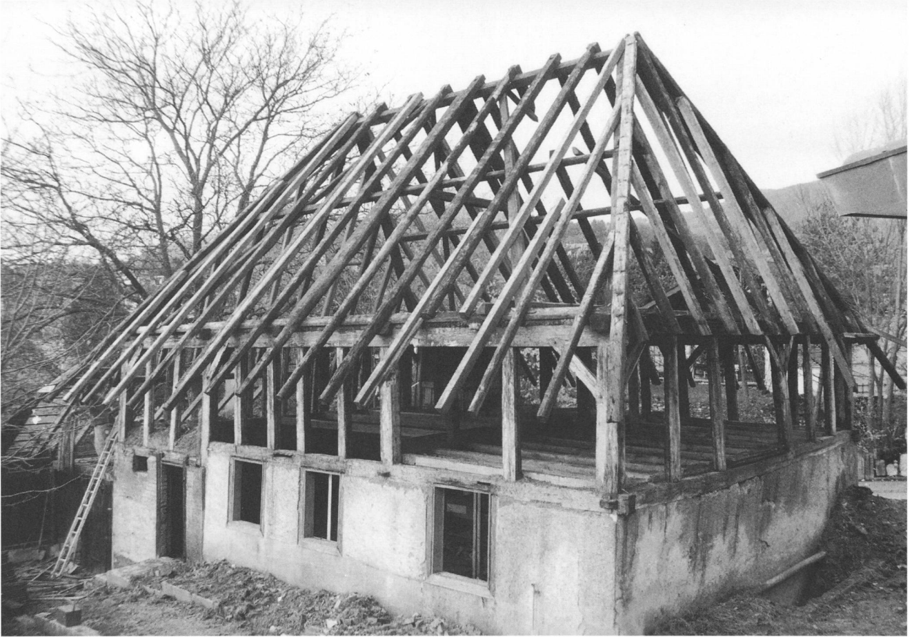
Abb. 9 Das ganze Obergeschoss ist in Gerüstbauweise erstellt. Vor dem Einbau der Ziegelbedachung musste der Dachstuhl mit zusätzlichen Rafen (hell) verstärkt werden. Fotos: Hans A. Sigrist
