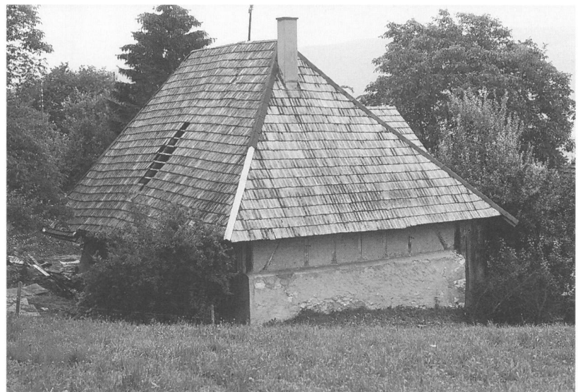
Abb. 2 Ulrich Fluris Elternhaus, Nr. 111, stand nur einen Steinwurf weit von seinem Neubau entfernt am Kohlholzweg. Leo von Wartburg, der letzte Eigentümer, liess es im August 1977 abbrechen.
