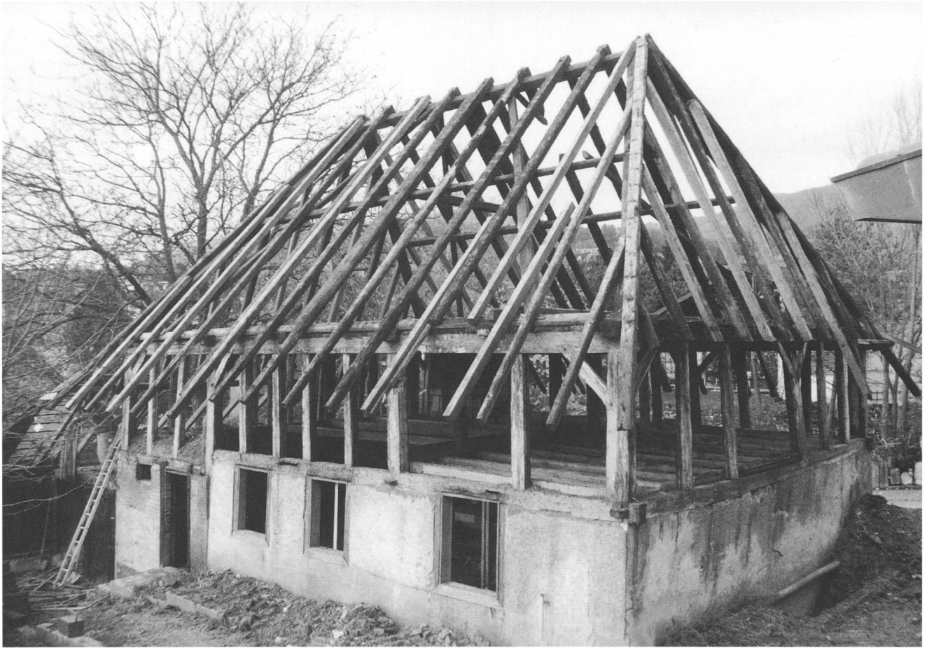
Abb. 9 Das ganze Obergeschoss ist in Gerüstbauweise erstellt. Vor dem Einbau der Ziegeldachdeckung musste der Dachstuhl mit zusätzlichen Rafen (hell) verstärkt werden. Fotos: Hans A. Sigrist
