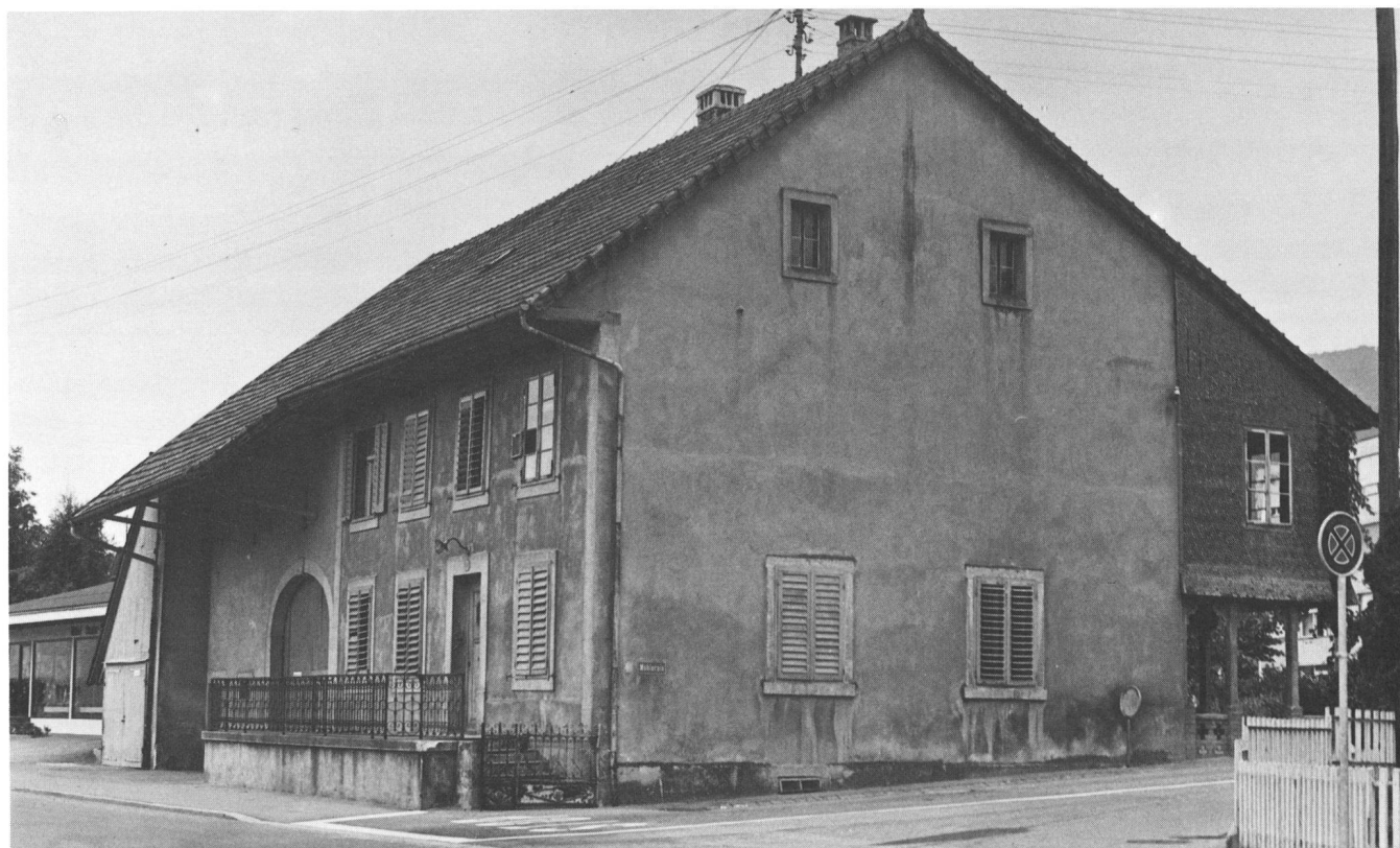
Das Kamberhaus ist im September 1985 abgebrochen worden.
