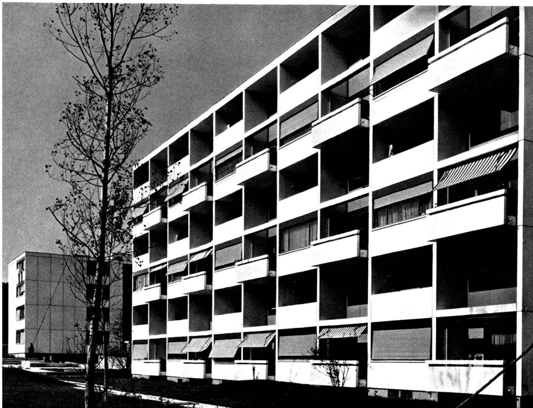
De gauche à droite et de bas en haut: Bâtiments 9 et 8 vus de l'est. Bâtiment 9 vu du sud. Bâtiment 5: 30 appartements duplex. Bâtiment 8 vu de l'ouest: appartements «split-level» et studios.
