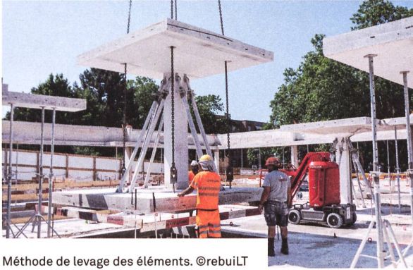
Méthode de levage des éléments. ©rebuiLT
