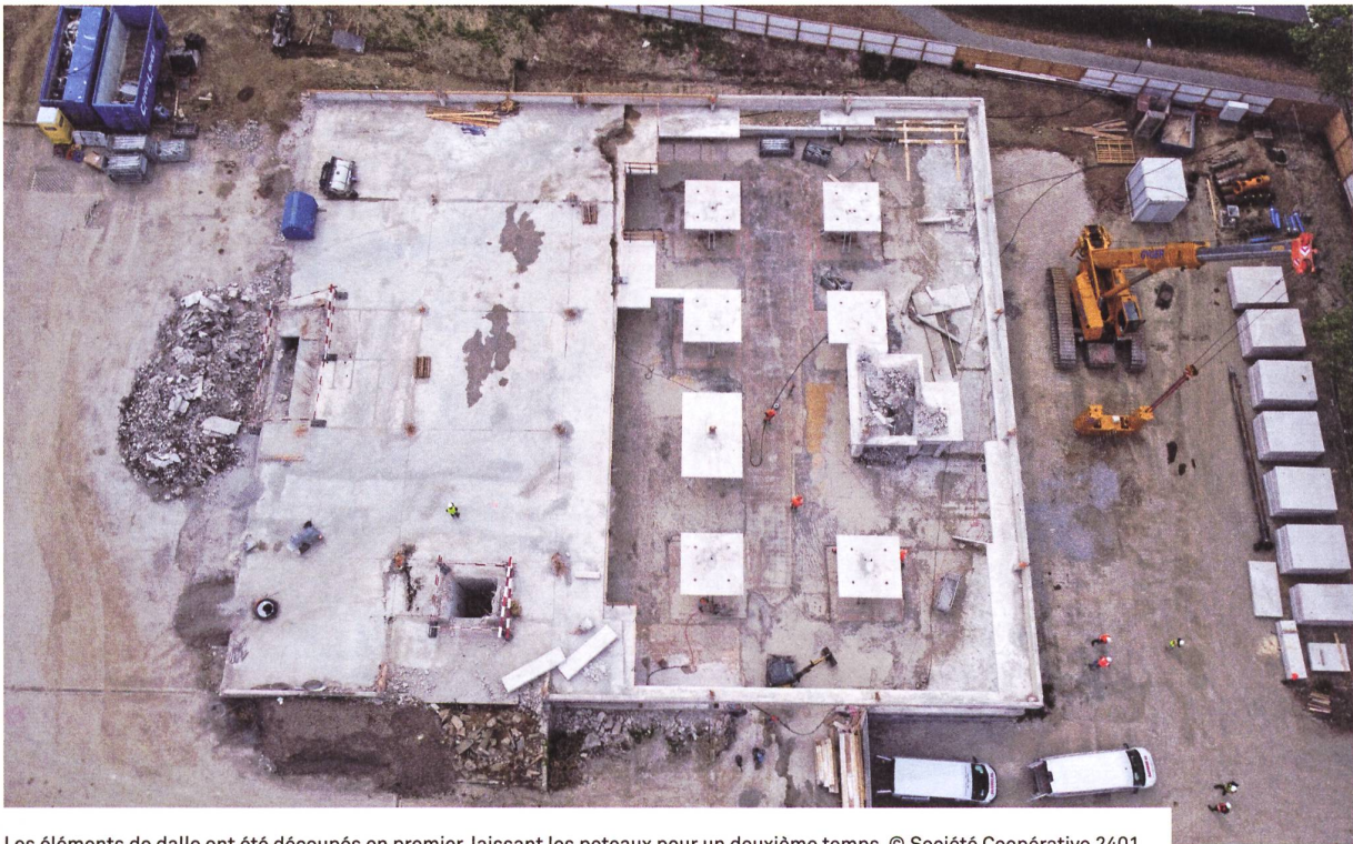
Les éléments de dalle ont été découpés en premier, laissant les poteaux pour un deuxième temps. © Société Coopérative 2401
