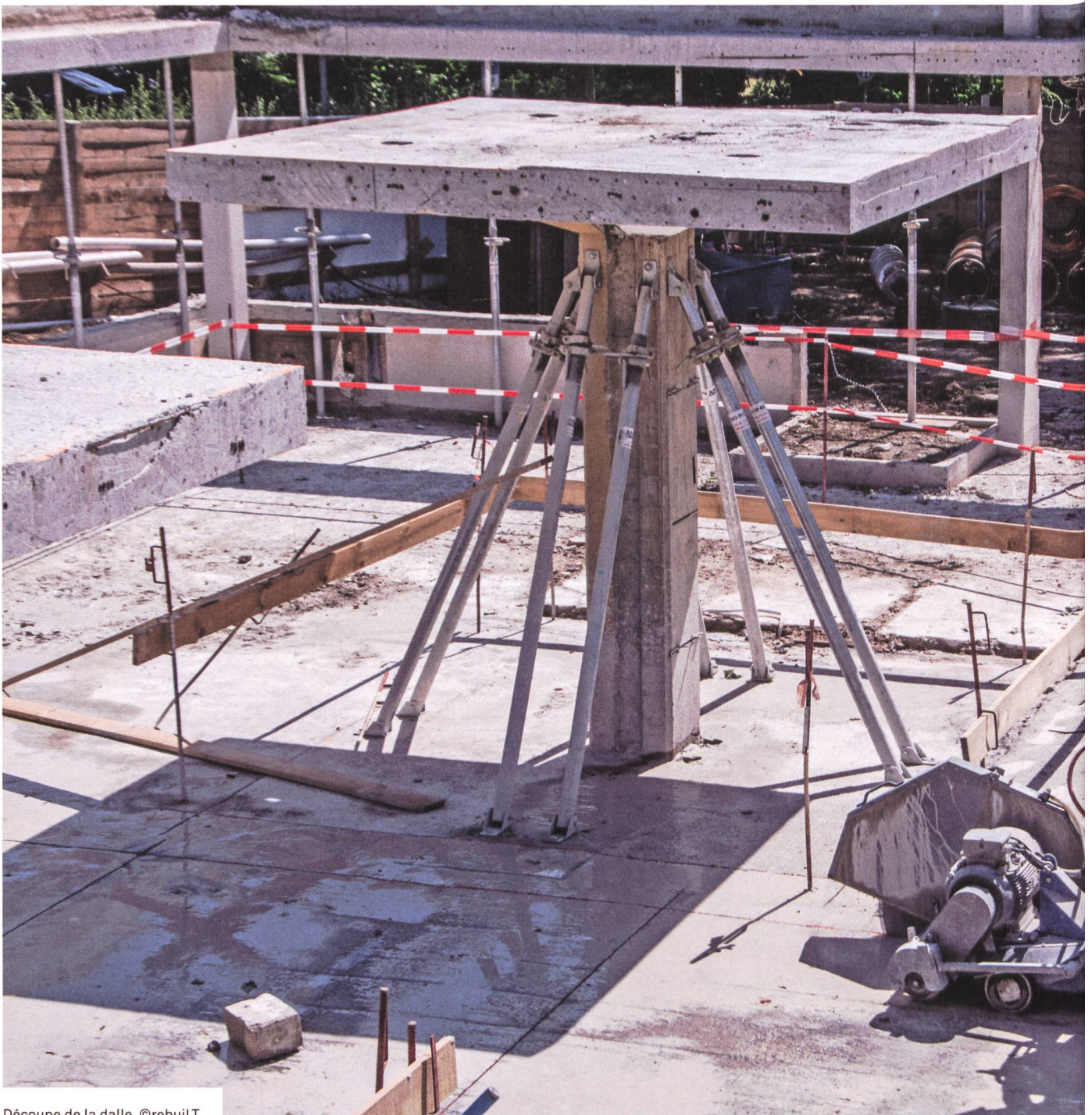
Découpe de la dalle. ©rebuiLT
