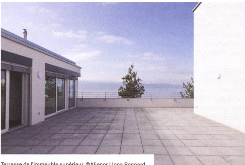
Terrasse de l'immeuble supérieur. ©Alienor Llona Bonnard
