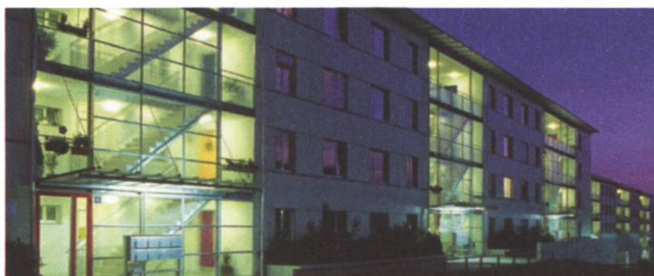
La technologie Connected Lighting tient également compte de la lumière du jour et ne s'allume même pas lorsqu'il fait suffisamment clair.
