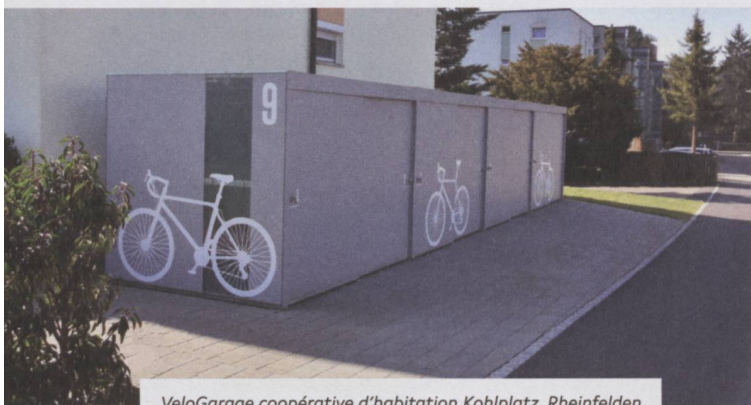
VeloGarage coopérative d'habitation Kohlplatz, Rheinfelden
