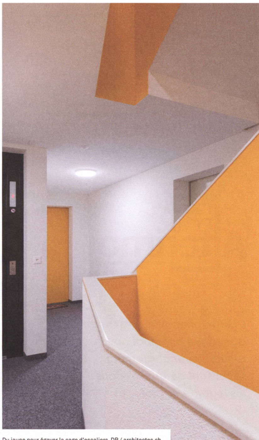
Du jaune pour égayer la cage d'escaliers. DR / architectes.ch
