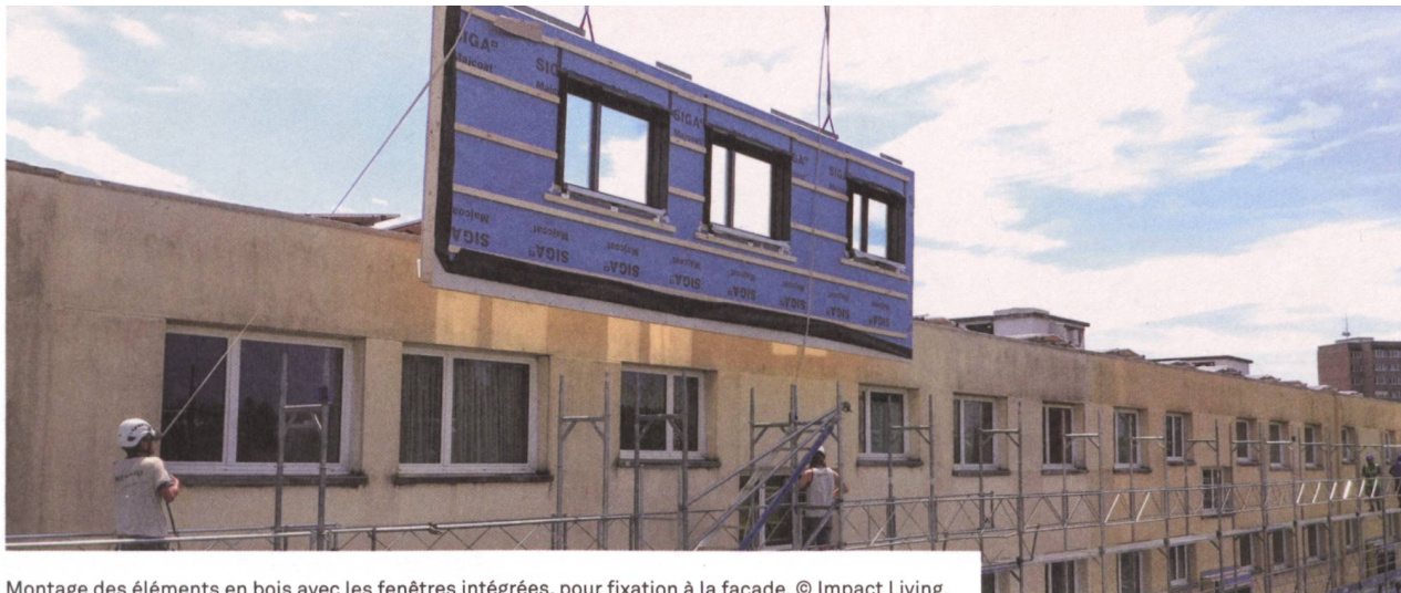
Montage des éléments en bois avec les fenêtres intégrées, pour fixation à la façade. © Impact Living.
