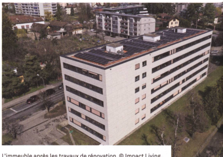
L'immeuble après les travaux de rénovation. © Impact Living.
