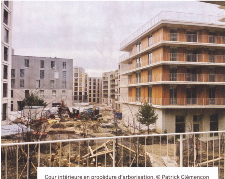
Cour intérieure en procédure d'arborisation. © Patrick Cléménçon
