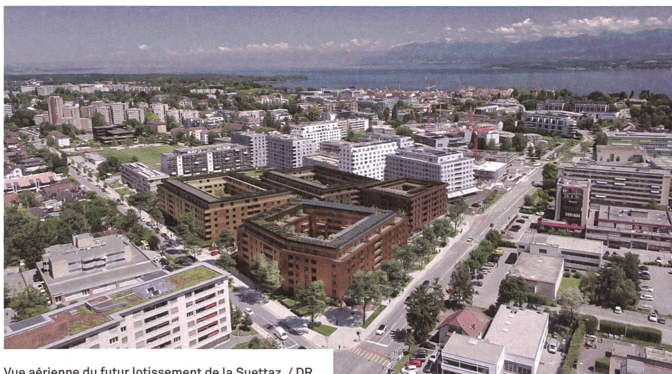
Vue aérienne du futur lotissement de la Suettaaz. / DR
