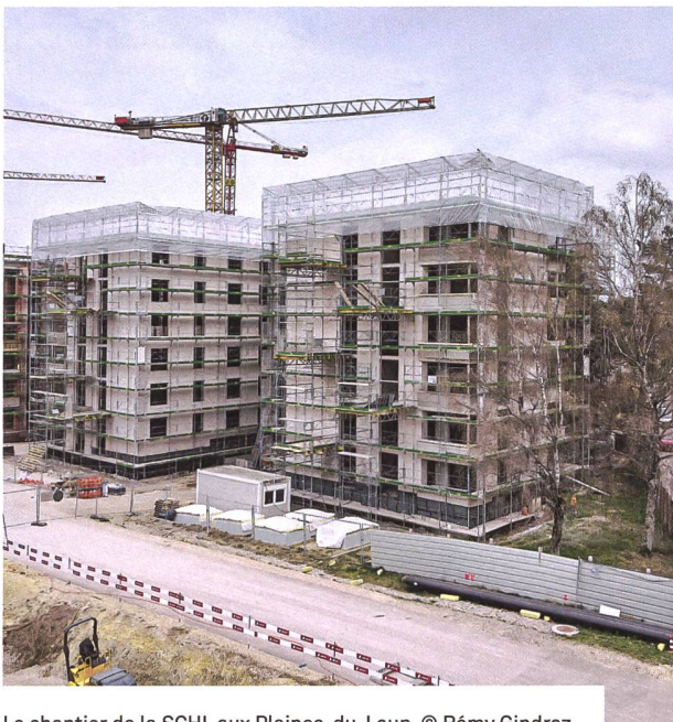
Le chantier de la SCHL aux Plaines-du-Loup. © Rémy Gindroz
